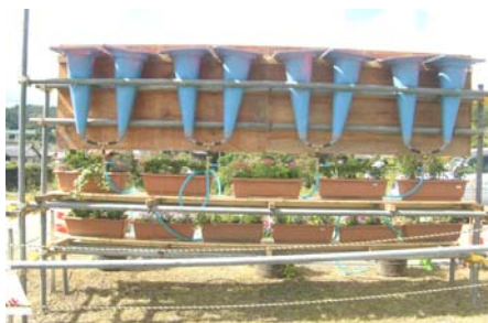
□ 工事用看板に取付けた、雨水利用のピーアール
