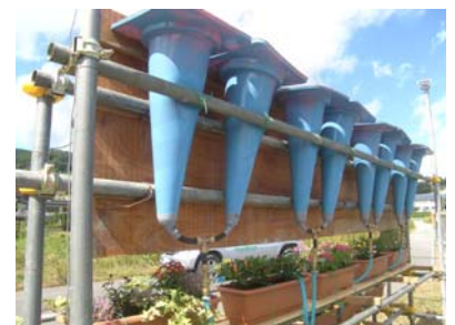
□ 工事用コーン活用の雨水集水装置
